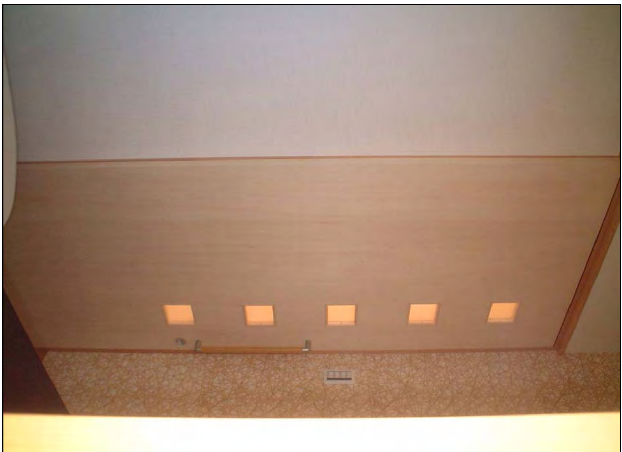
片引き込みガラスフラッシュ戸 面材:シナ合板(クリア塗装)
