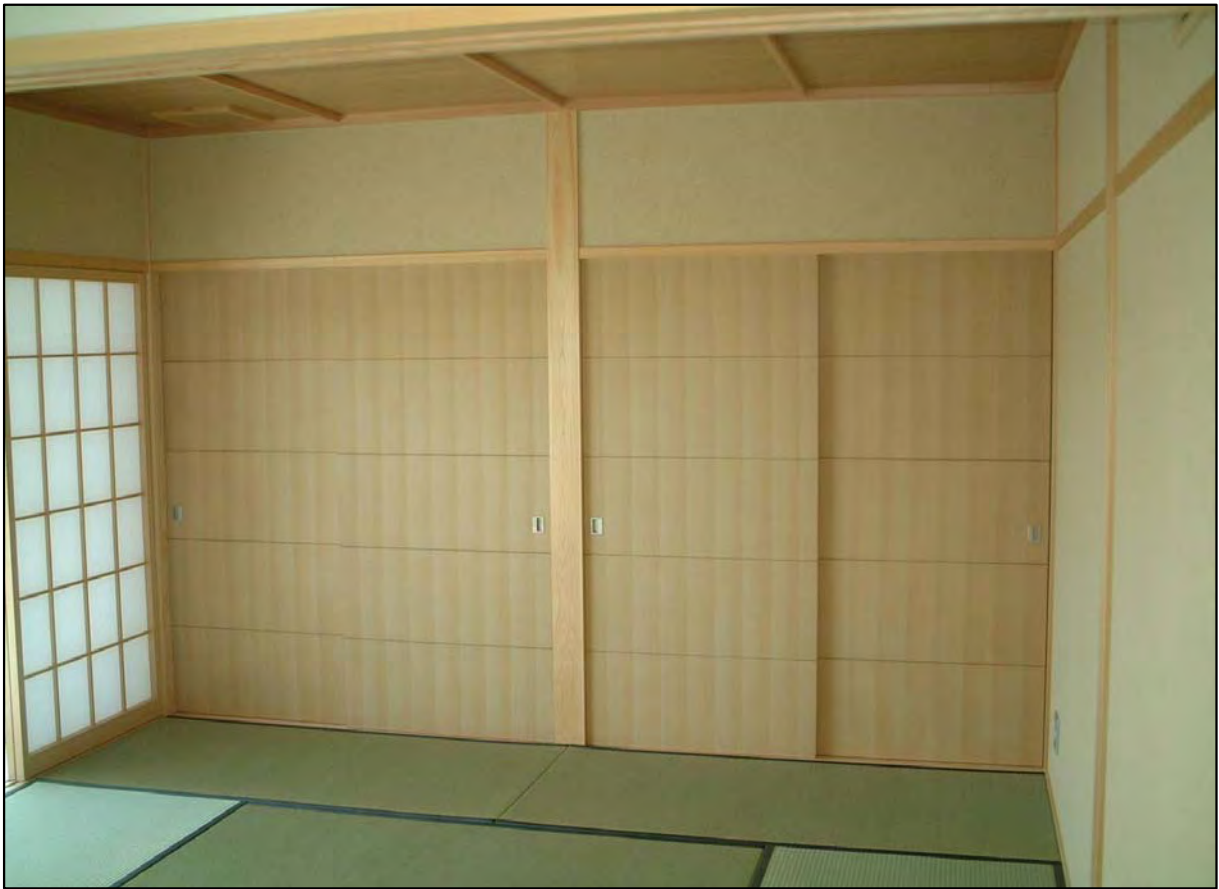
片吊引き込みフラッシュ戸(目地付き) 面材:ナラ突板(クリア塗装) 金物:吊金物 アトム AFD
