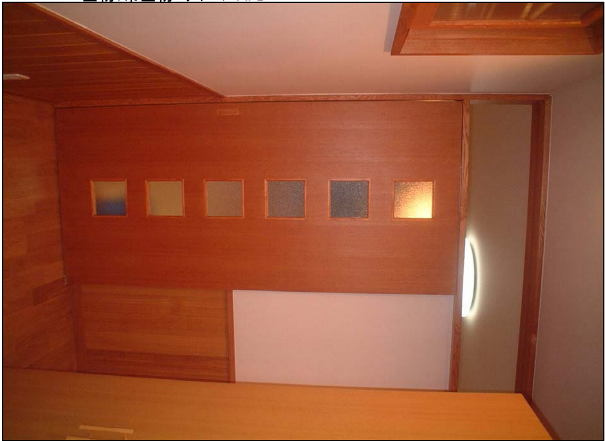
片引き込みガラスフラッシュ戸 面材:シナ合板(クリア塗装)
