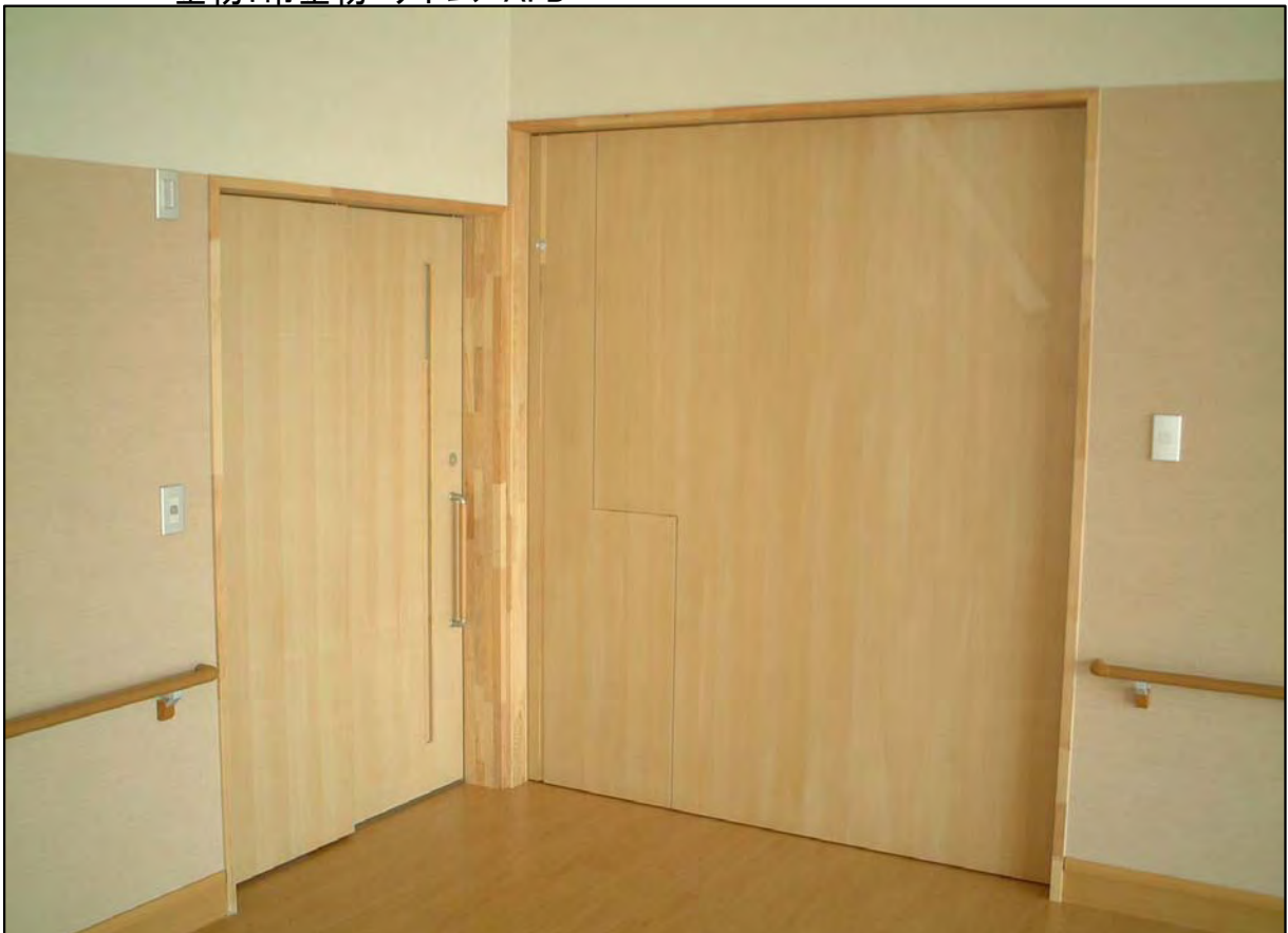
片吊引き込みフラッシュ戸(目地付き) 面材:ナラ突板(クリア塗装) 金物:吊金物 アトム AFD
