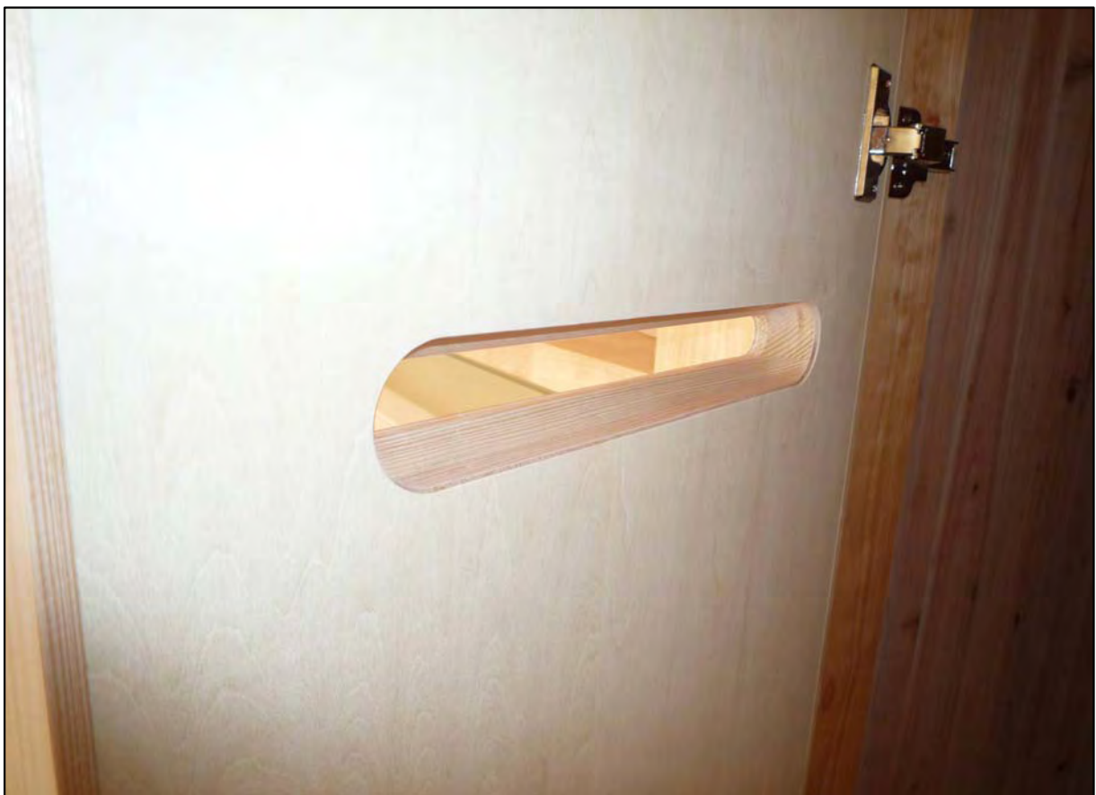
彫り込み引き手 細いスリットがそのまま引き手。デザイン性と機能性を兼ね備えた引き手。
