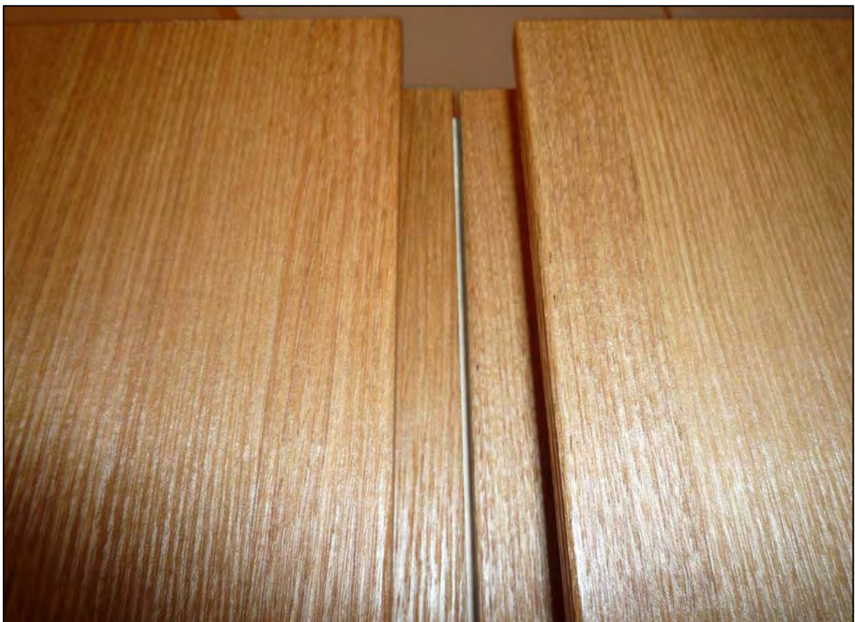
彫り込み引き手 無垢材ならではのどこでも手が掛けれる引き手 面材と同材で製作するので同化 撮影日 平成22年8月26日
