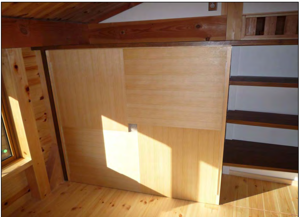
1本引きフラッシュ戸 面材:パイン柾目突板(クリア塗装)
