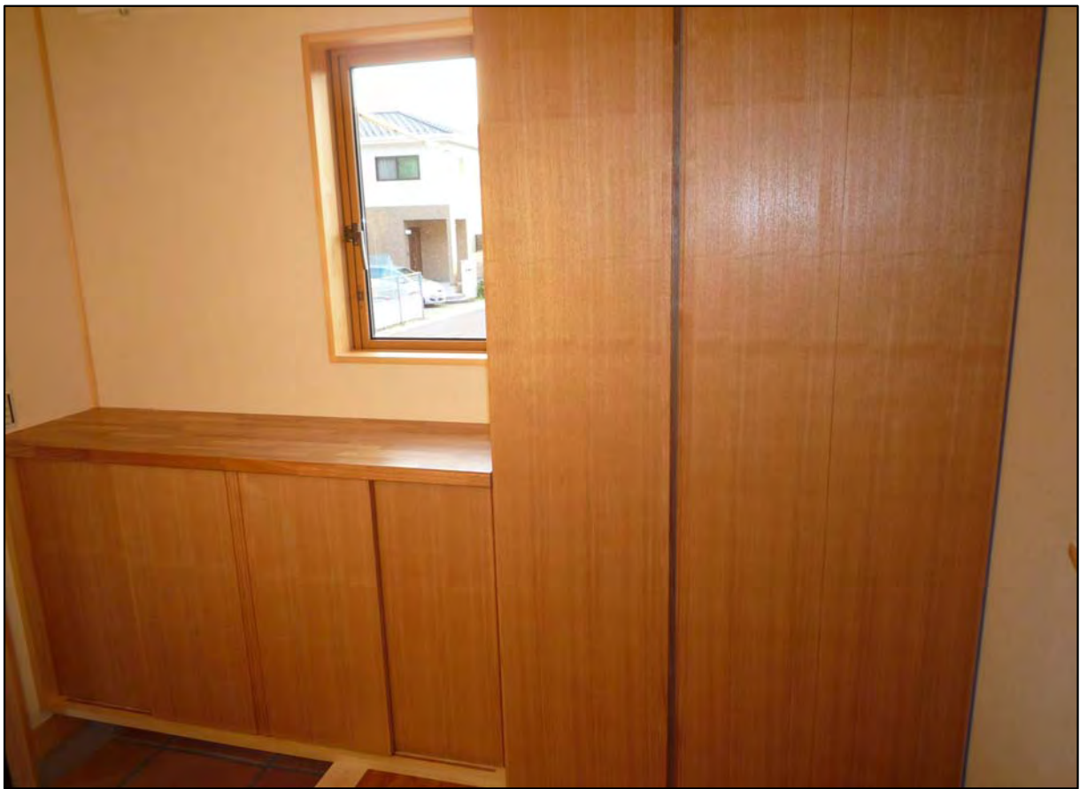
彫り込み引き手 無垢材ならではのどこでも手が掛けれる引き手 面材と同材で製作するので同化 撮影日 平成22年8月26日
