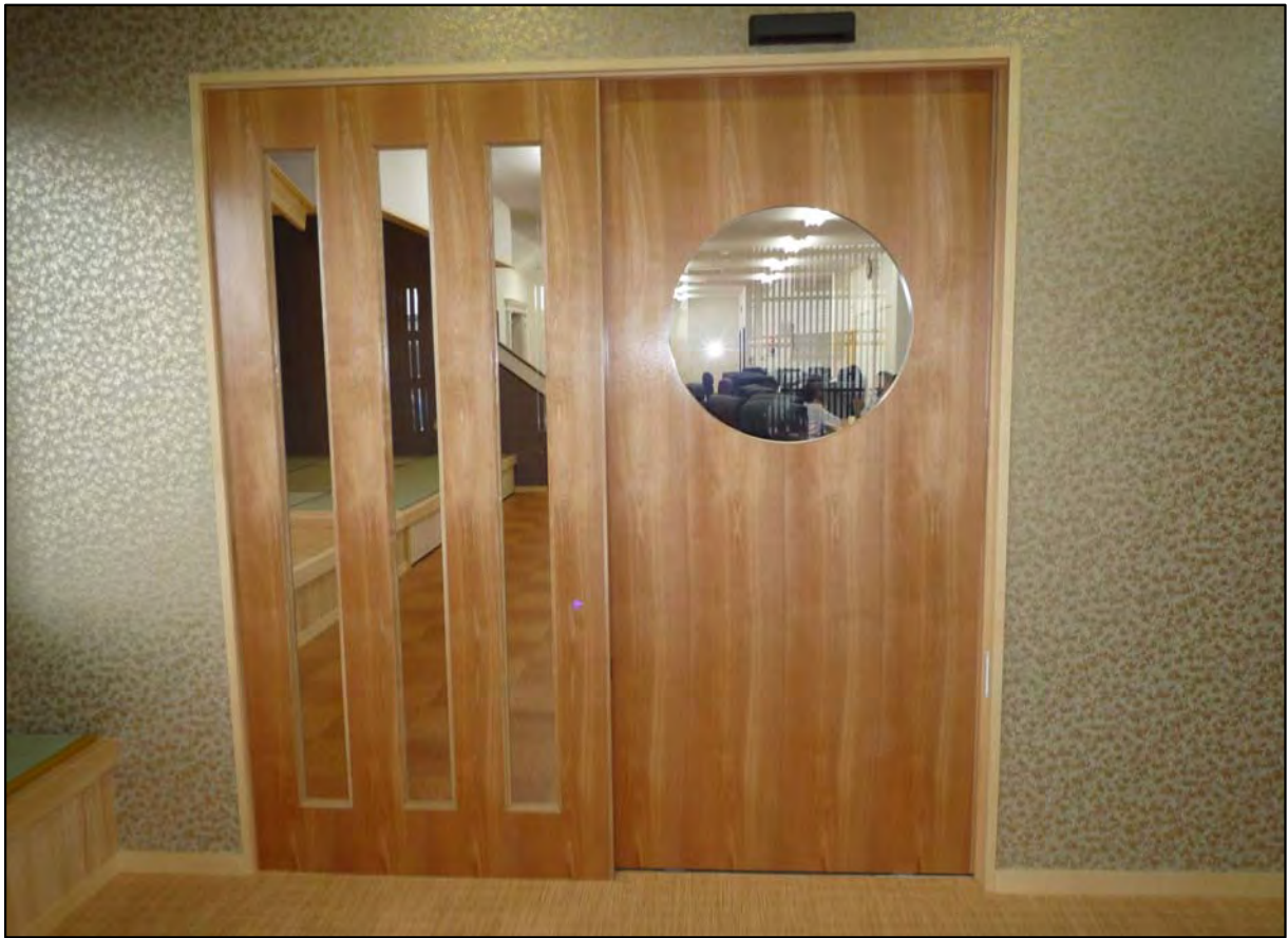
1本引きフラッシュ戸 面材:パイン柾目突板(クリア塗装)
